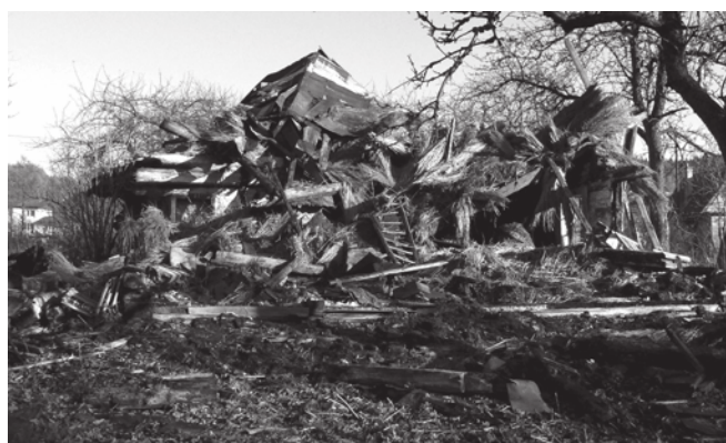
Jest 17 listopad 2006 roku. To południowa strona budynku. Od północnej strony został jeszcze „kawałek” chałupy. Tym sposobem zniknęła ostatnia chata słomą kryta. A szkoda!
